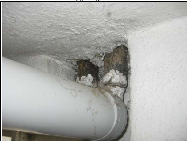
Oprindelige stigrør er genbrugt ved ombygningen – facadevæg i kælderetage
