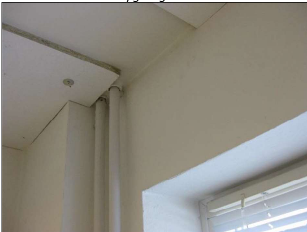
Oprindelige stigrør er genbrugt ved ombygningen - kælderetage
