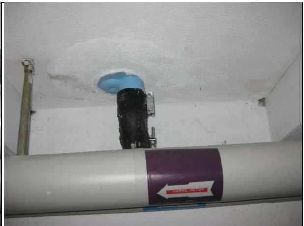
Synlig gulv afløbsskål i plast i kælderen
